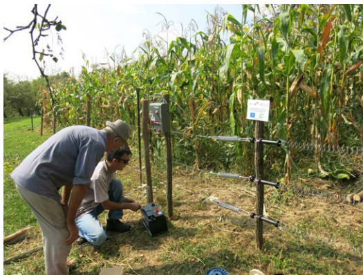
Instalarea de garduri electrice și instruirea proprietarilor pentru utilizarea acestora.
